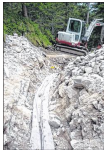
Die Abwässer können jetzt ins Tal abgeleitet werden.
